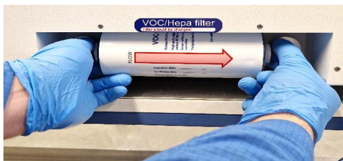
Figur 12.2 Fremgangsmåde for isætning og fjernelse af VOC/HEPA-filter
